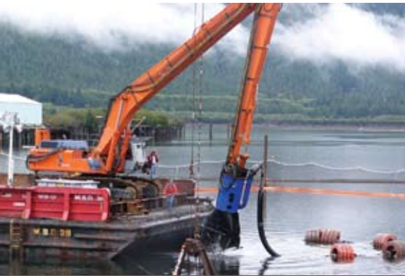
Dragage de précision à basse turbidité de sédiments contaminés aux BPC
