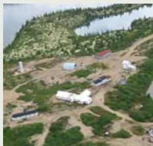
Réhabilitation environnementale – Nitchequon
