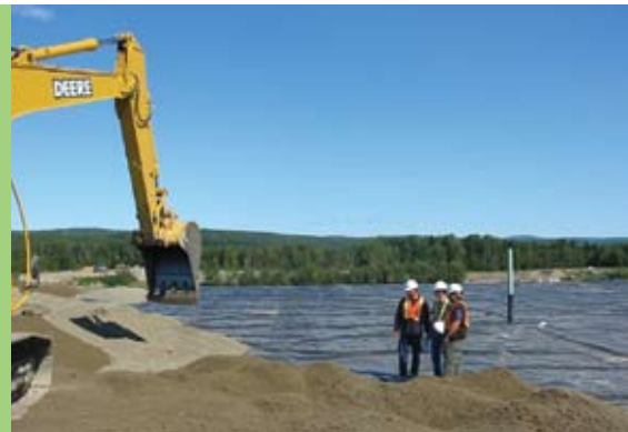
Recouvrement d'un site d'enfouissement
